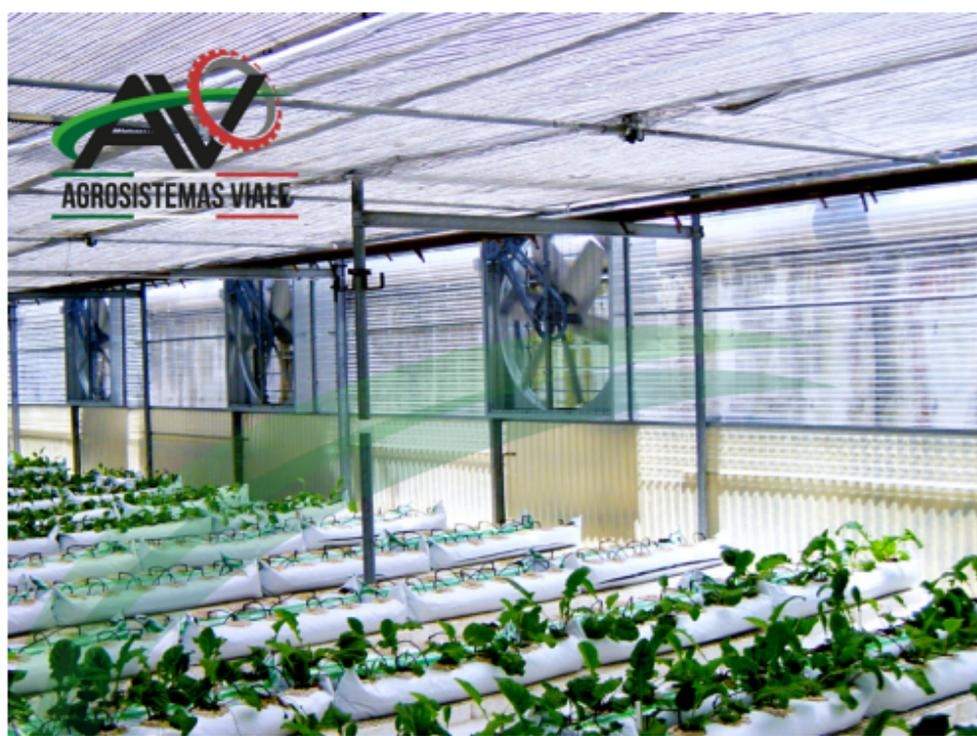
Cuenta con protección de aire y luz gracias a las juntas que permiten un cierre perfecto de las aletas, opcionalmente incluye una rejilla externa de protección y fijación de casquillo roscado, además de un panel inferior con 4 prácticos orificios de descarga de agua.
