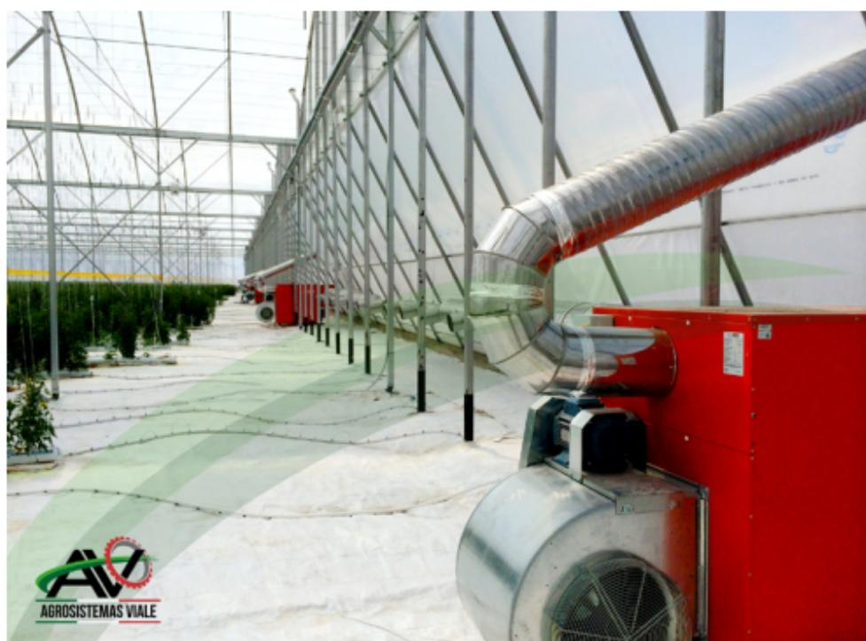
Gracias a la alta calidad, rendimiento e innovador diseño de la caja de protección y accesorios, se logra resultados muy positivos en términos de manejo, transporte y facilidad de instalación. Tiene una potencia térmica de 35 a 240 kW, y está disponible en GLP, diésel, querosén y gas metano.
