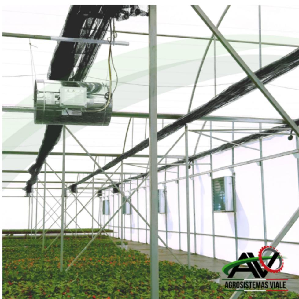
Tiene 4 ganchos de suspensión, botón de restablecimiento remoto, toma de termostato, conexiones de gas/electricidad prácticas y termostato de seguridad con reinicio manual.
