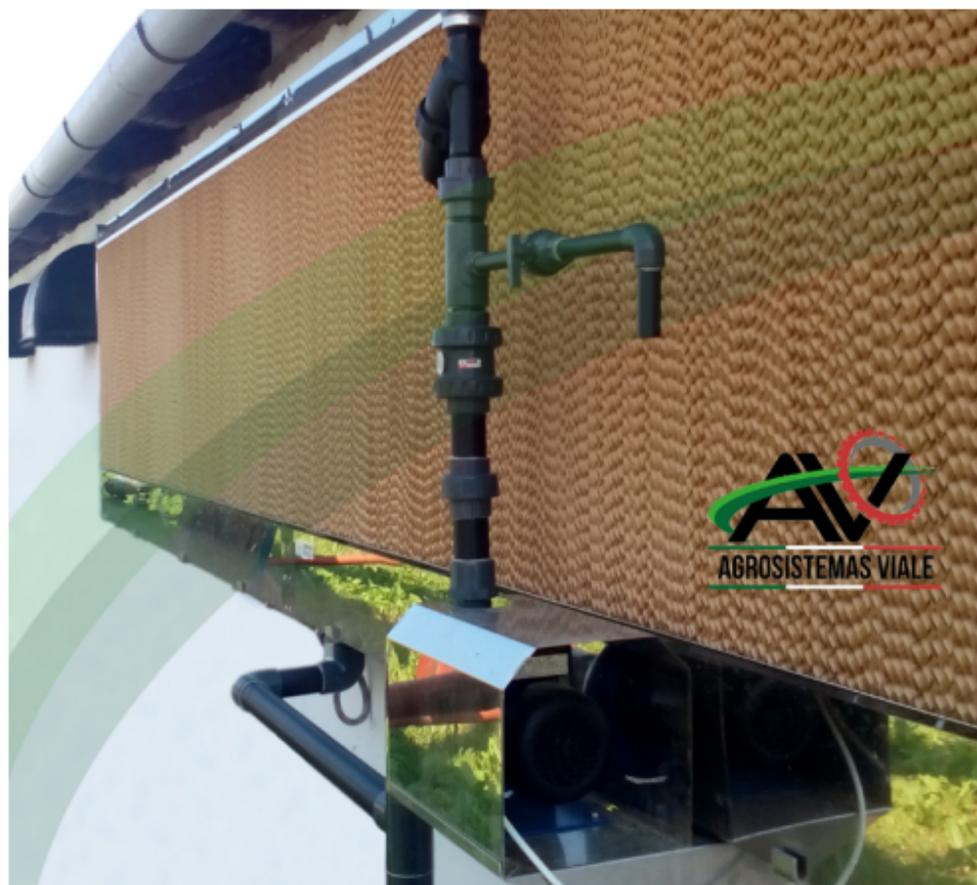
Los paneles se humedecen con un sistema de distribución de agua para impregnar uniformemente la estructura alveolar especial del panel. En ese momento el aire que pasa a través de él cederá una parte del calor a agua que causa la evaporación.
